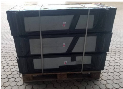
Nachtspeicheröfen abgeklebt und gestapelt auf einer Palette.
